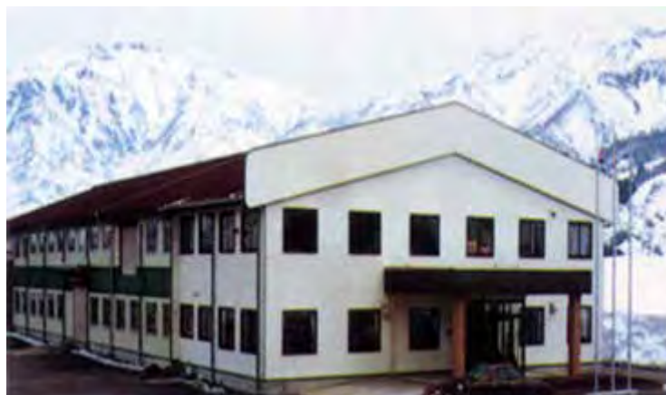
<昭和 59 年 7 月 新潟県六日町に高速紙工業(株)新設>
